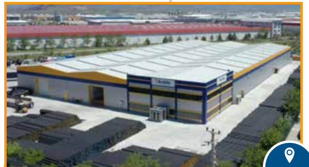
Koruge Sistemleri Üretim Tesisi
